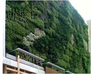
صورة 1: تركيب الوحدات الخضراء بالواجهات نيويورك- www.greenroofs.org
