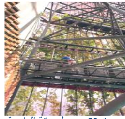
صورة 63: ممر لصيانة الواجهة -المصدر ARCHDAILY.COM
