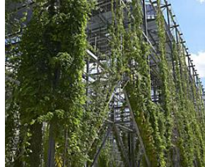
صورة 2: MFO بارك واجه الكابلات و الشبكات بسويسرا- www.greenroofs.org
