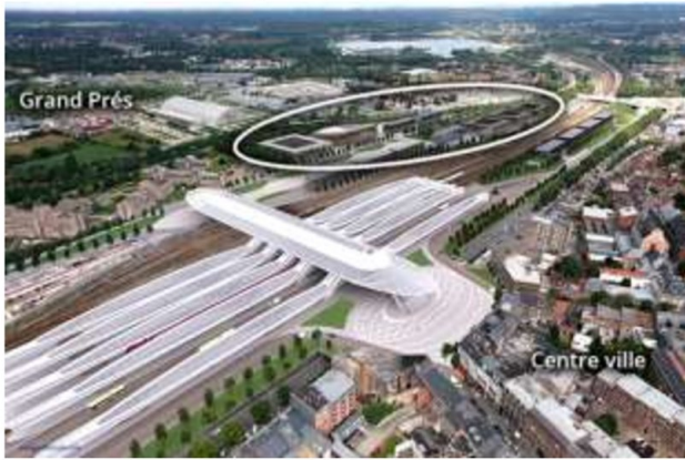
الصورة رقم (34) منظر فضائي لتركيبية لمحطة مونس
