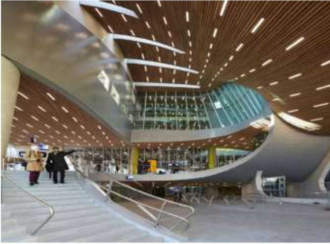
الصورة رقم (45) منظر داخلي للمحطة - أرنيم
