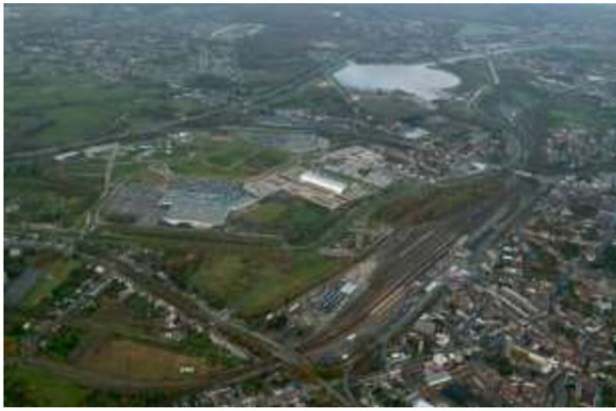
الصورة رقم (33) منظر فضائي لمحطة مونس
