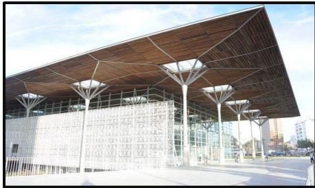
الشكل 81: صورة توضح امتداد السقف وراء الواجهات بمحطة قطار الدار البيضاء
