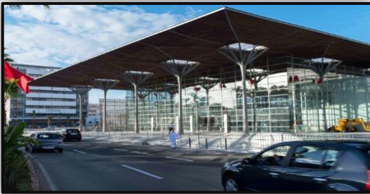
الشكل 42: صورة توضح الواجهات المكسوة بالزجاج الشفاف لمحطة قطار الدار البيضاء المصدر: (https://www.archdaily.com.03/02/2021)
