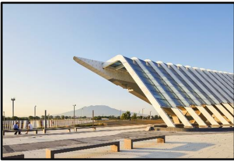
الشكل 62: صورة توضح الأعصاب الحديدية المكونة لهيكل محطة نابولي
