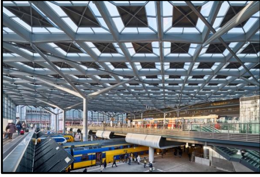
الشكل 86: صورة توضح الأعمدة الحاملة لسقف محطة لاهاي المركزية
