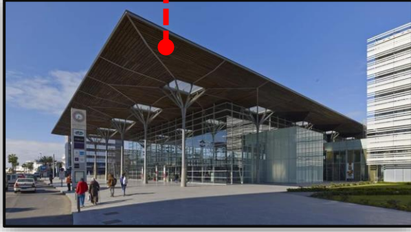
الشكل 28: صورة توضح السطح الممتد فوق الواجهة الجنوبية لمحطة قطار الدار البيضاء
