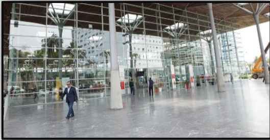
الشكل 38: صورة توضح تغطية الأرضية بالحجر الجيري داخل وخارج محطة قطار الدار البيضاء
