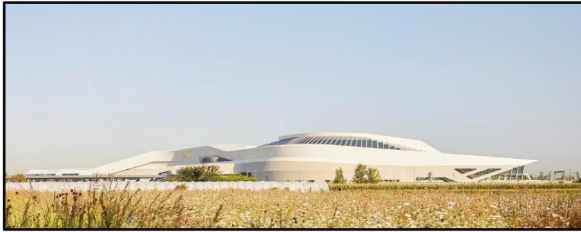
الشكل 53: صورة لواجهة محطة نابولي
