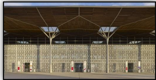
الشكل 43: صورة توضح المشربية المكونة من الخرسانة المسلحة بالألياف بمحطة قطار الدار البيضاء المصدر: (https://www.archdaily.com.03/02/2021)
