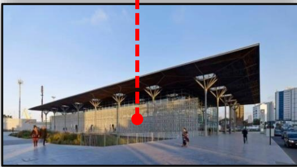
الشكل 27: صورة توضح المشربية في الواجهة الغربية لمحطة قطار الدار البيضاء
