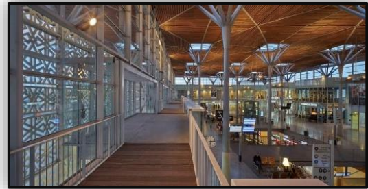
الشكل 41: صورة توضح تكوين الجزء السفلي من الخشب لسقف محطة قطار الدار البيضاء المصدر: (https://www.archdaily.com.03/02/2021)
