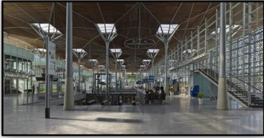
الشكل 40: صورة توضح تكوين الأعمدة من الخرسانة والفولاذ داخل محطة قطار الدار البيضاء المصدر: (https://www.archdaily.com.03/02/2021)
