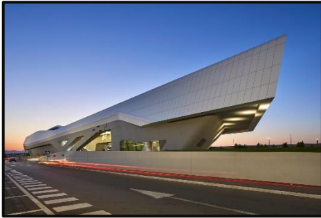
الشكل 64: صورة توضح التغطية الخارجية من الكوريان لمحطة نابولي
