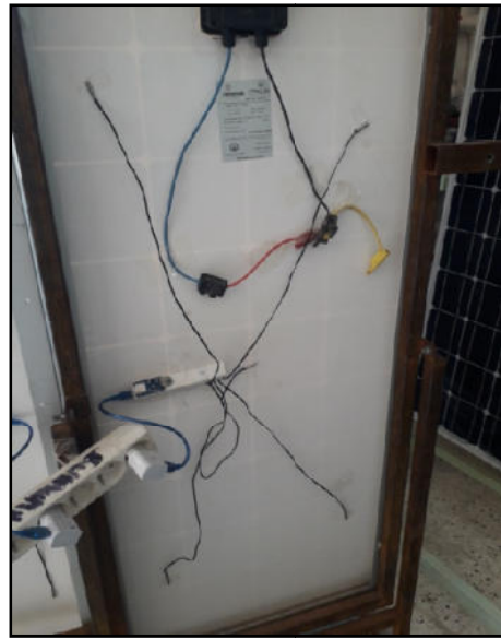
Figuré.3 : Panneau Non dégradé en Bas
