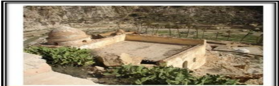
صورة توضح الشكل الخارجي لمسجد سيدي موسى بن عابد في دشرة اث ميمون
