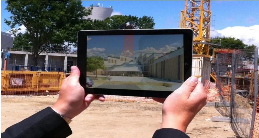
**Figure1.9.**Application de réalité augmentée pour le chantier de l'école d'ingénieur Ensibs, à Lorient
