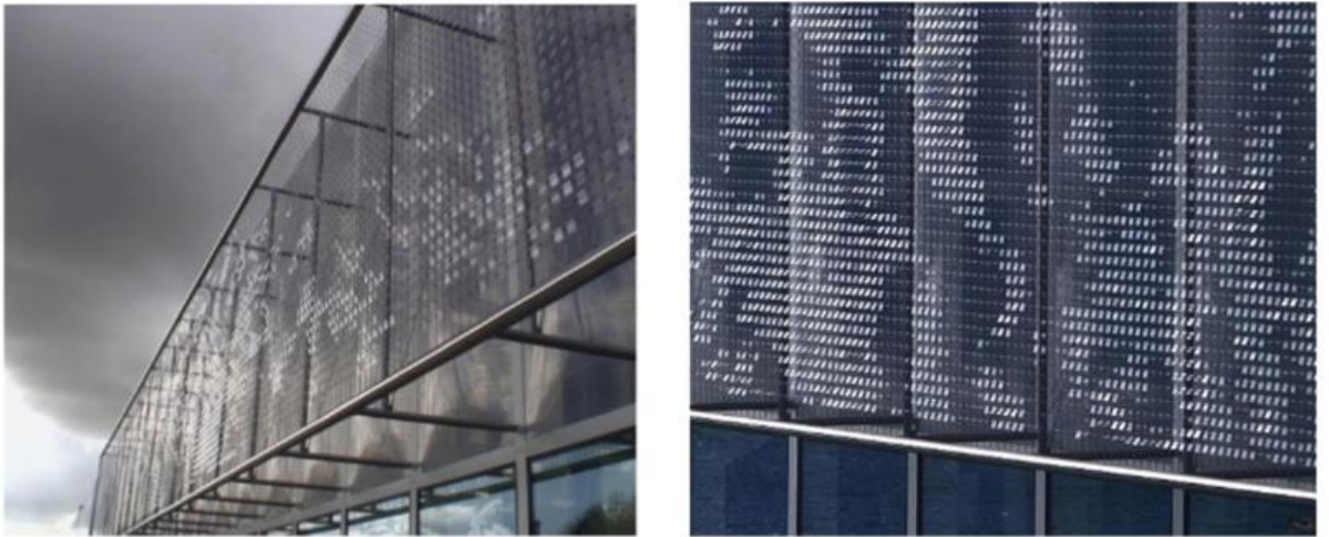
Figure III.6. Façade d'un bâtiment de bureau à Utrecht au Pays bas [5].
