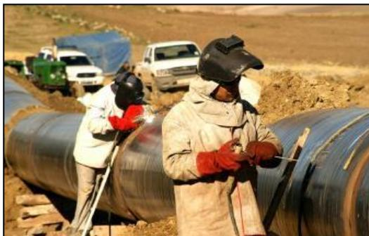
**Figure I.1 : Soudage manuel des pipelines (Projet EGPDF)**
