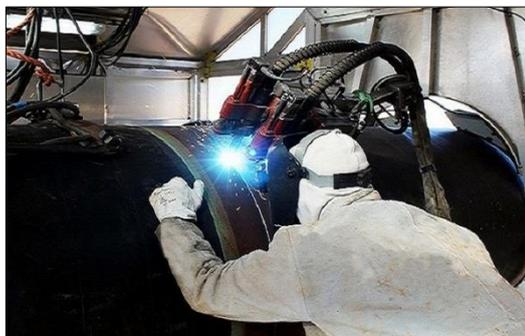
**Figure I. 2 : Soudage semi-automatique des pipelines (Projet GR5)**
