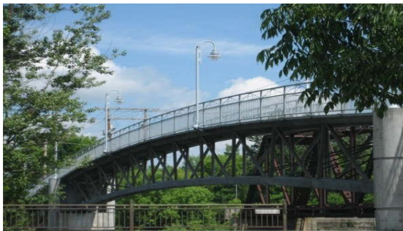
Figure I.2. Passerelle piétonnière de Sherbrooke réalisée en 1997.
