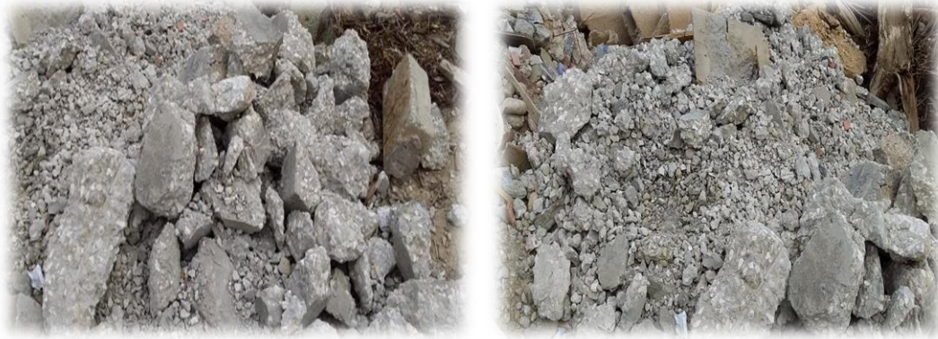
Figure 3.4 Béton de démolition
