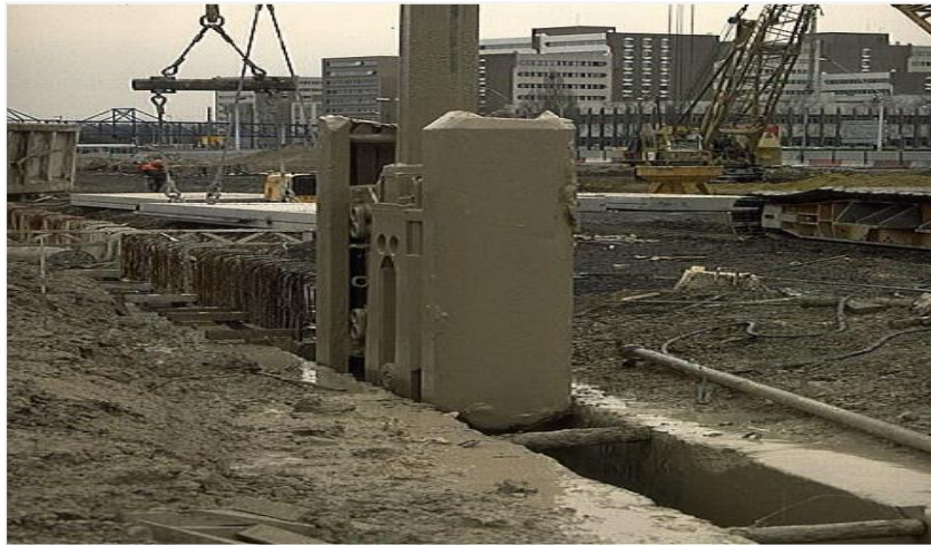
Figure I.7 : Les parois moulées
