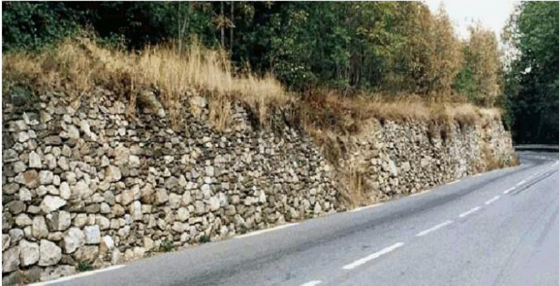
Figure I .5 : Mur en maçonnerie de pierres sèches
