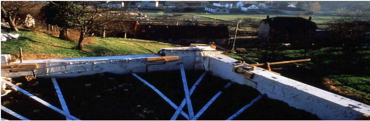
Figure I.4 : Renforcement par bandes métalliques.
