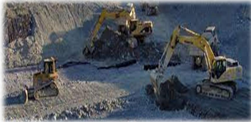
Figure 1.5 : Remblais sur sols compressible (France Maccaferri)
