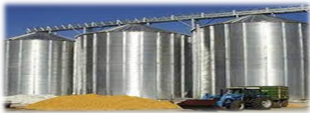
Figure 3.1 : Silos de stockage MECAFA Algérie
