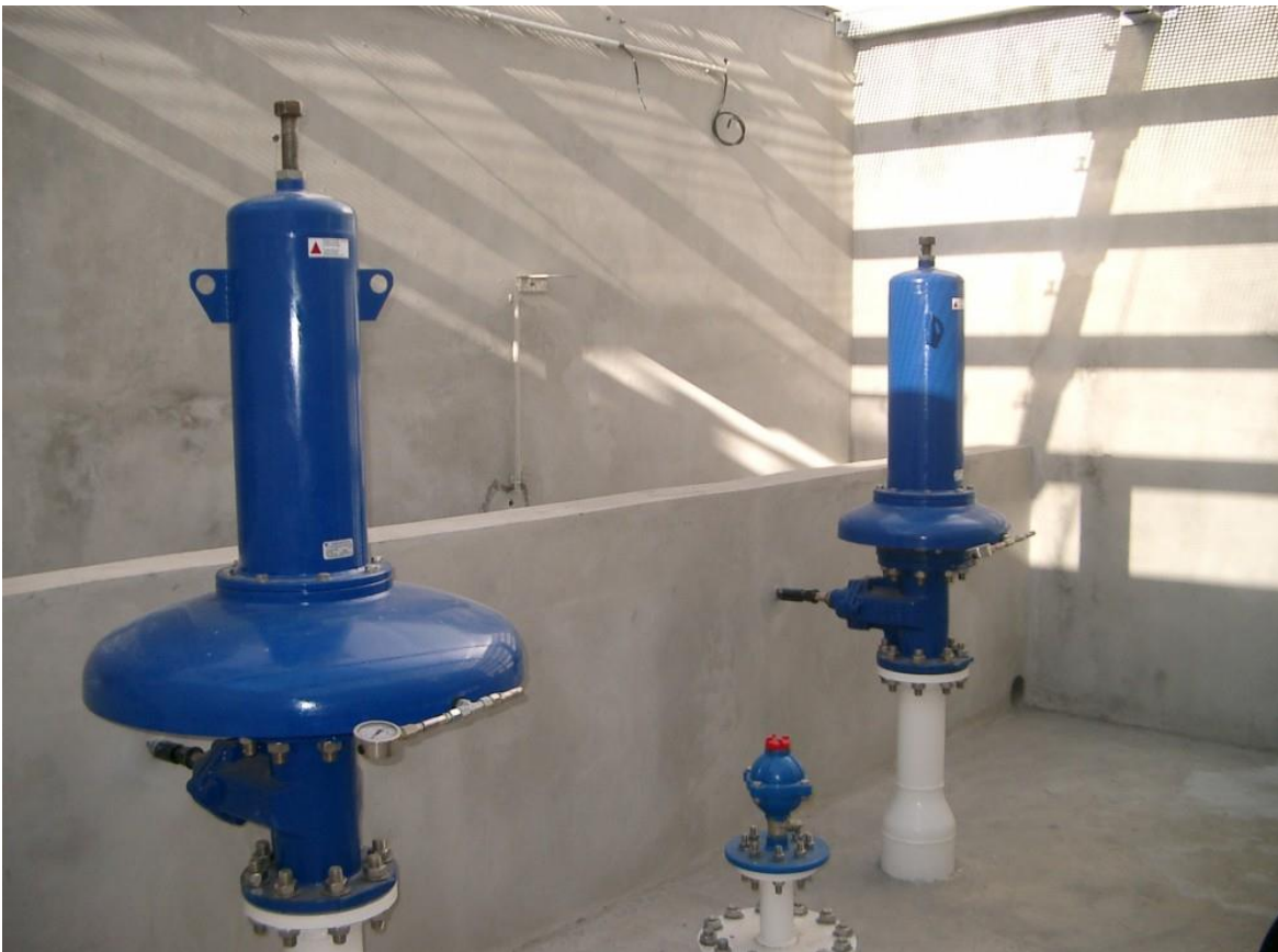
Figure III-5 : Soupapes de décharge Ramus.
