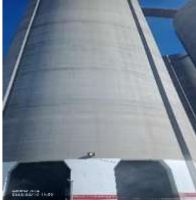
Figure I.24 : Le Silos de ciment
