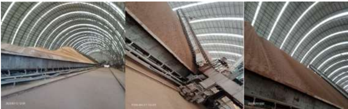
Figure I.15 : un hall à stockage linéaire
