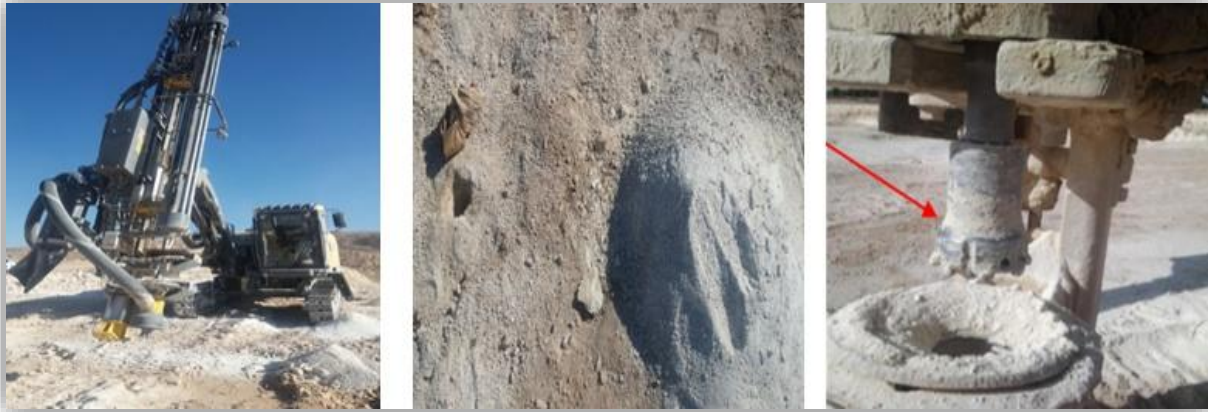
Figure I.3. Foration avec la sondeuse [Photo personnelle].
