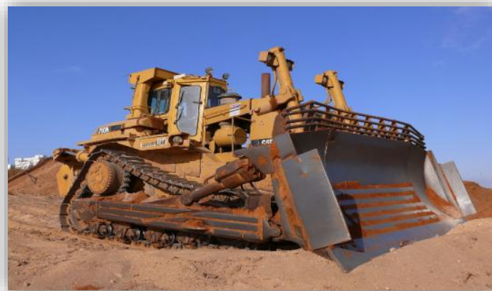
Figure I.2. Décapage et création de front avec bulldozer [Photo personnelle].
