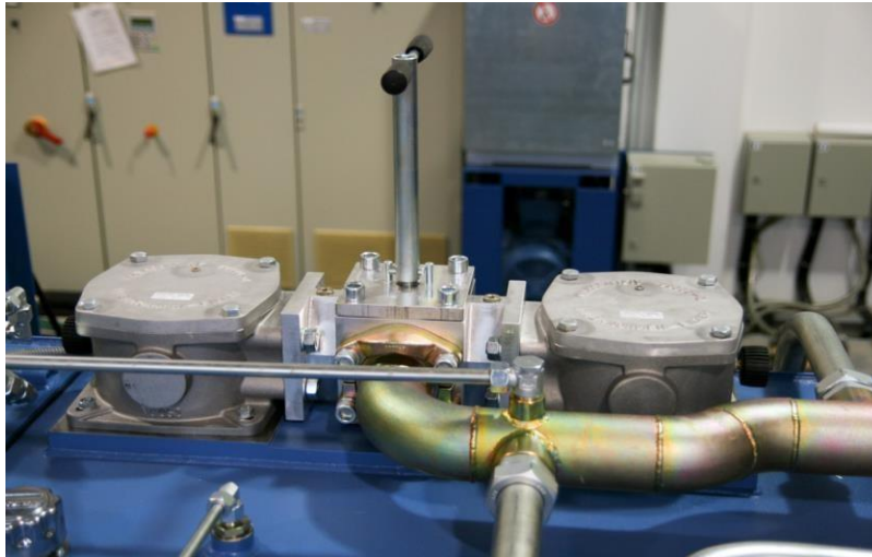
Figure II. 9 : Filtre à huile, avec système de surveillance continue de pression différentielle.
