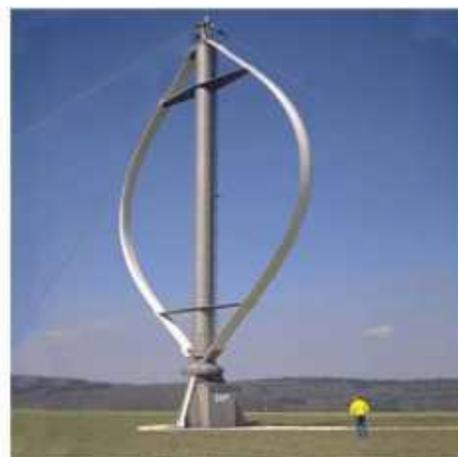
Figure I.5 : Eoliennes à axe Vertical (Savonius/Darrieus). [8]
