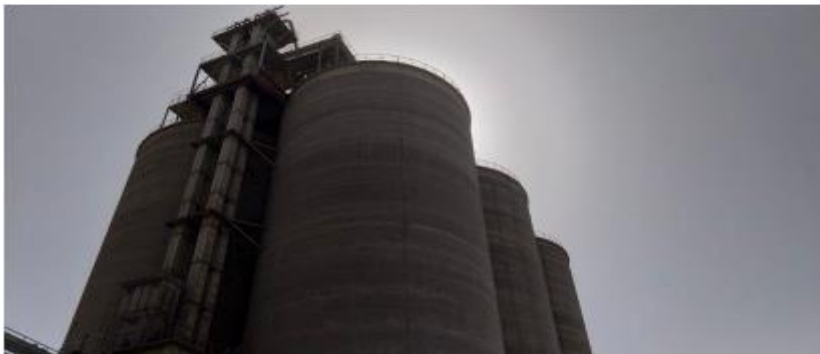
Figure I-6 : Silos de stockage de ciment
