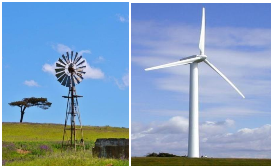
Figure I.7: Eolienne horizontale tripale et multi-pale [13].
