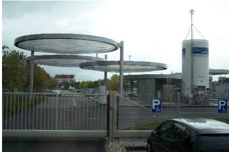
Figure(I.4) : Station-service cryogénique
