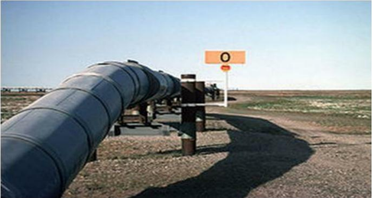
Figure II.1. Pipeline dans l'environnement
