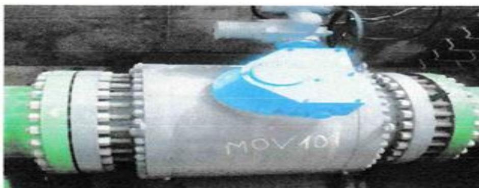
Figure I-4. Vanne de ligne (entre station).
