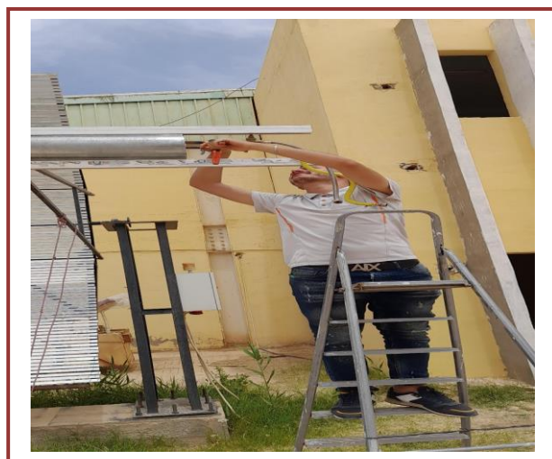
Figure 2.16 : Tube d'absorption et la couverture.
