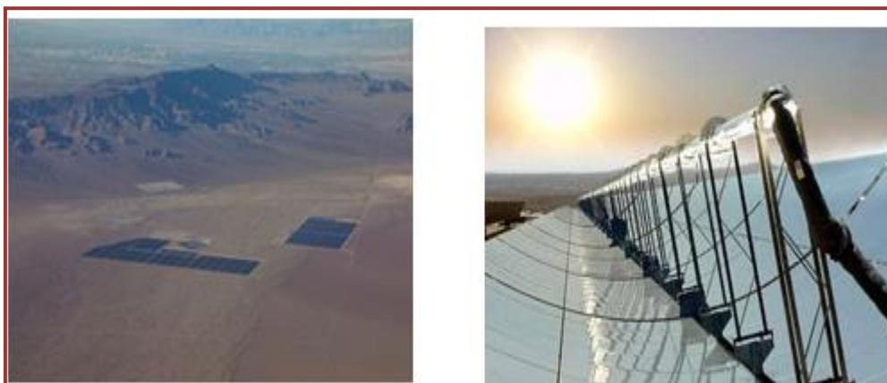
Figure 1.11 : Capteur cylindro-parabolique de la centrale de Nevada Solar One. [6]
