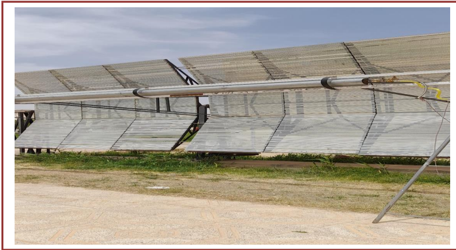
Figure 2.12 : Réflecteur cylindro-parabolique.
