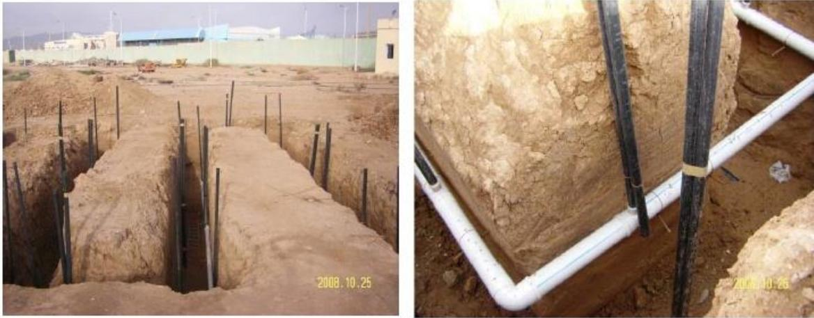
**Figure I.11 :** Echangeur air/sol enterré installé à l'université de Biskra [9]
