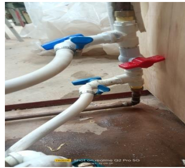
Figure (III.11) : Système de remplissage du circuit.
