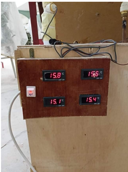
Figure (III.9): Installation des captures de mesure de température a entrée et la sortie De l'enceinte de stockage.
