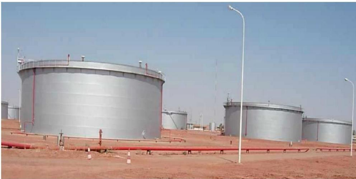
Figure I.5 : Réservoirs à toit flottant.
