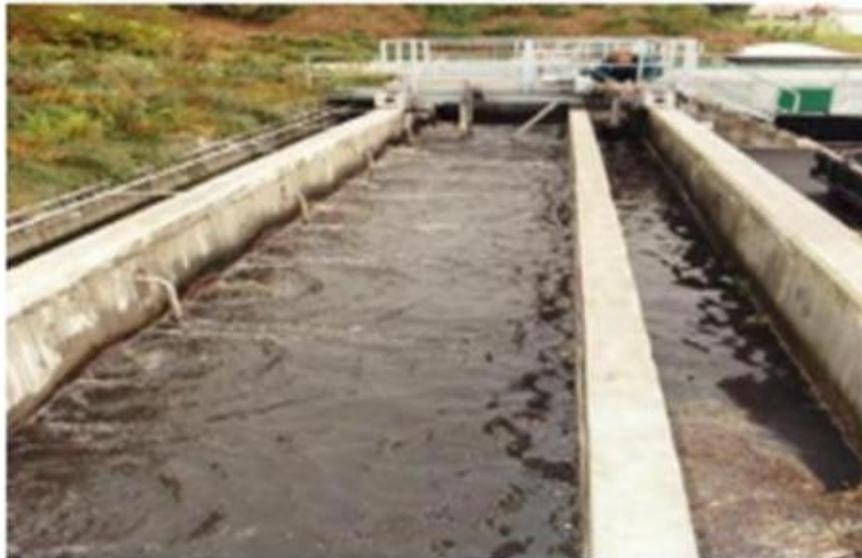
**Figure .3 : Schéma d'un désableur (source :Telli,2013)**
