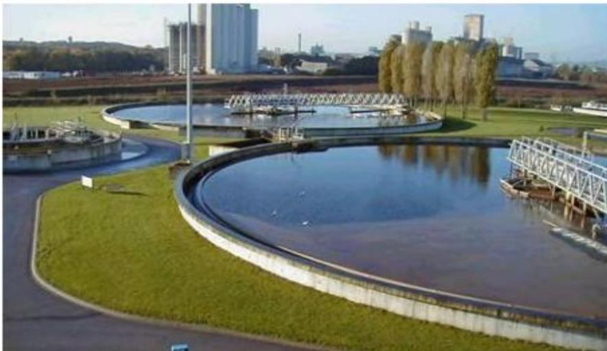
**Figure .10 : Décantation secondaire (source : Bakkal et Bennani,2012)**
