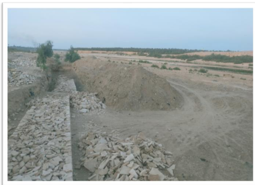
Photo n° 20 : Gabion sur de Oued Djedi (Labachi.H, 2022)
