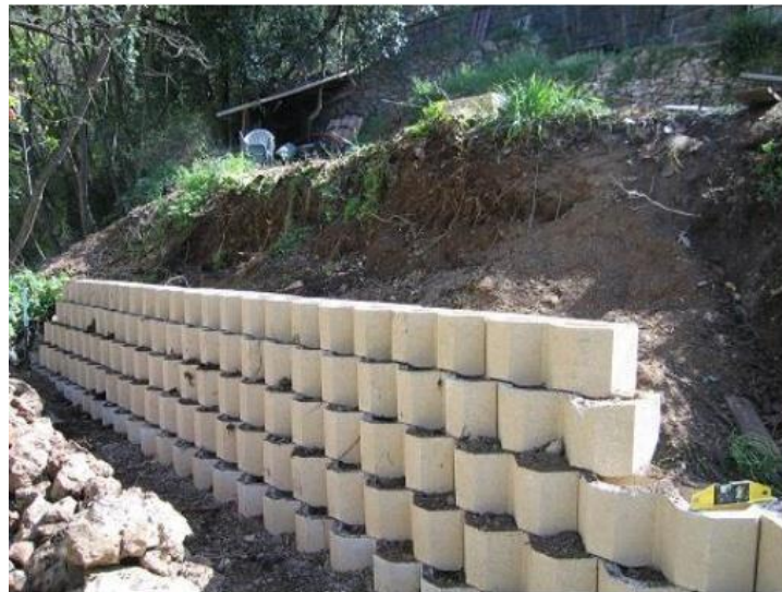
Photo n° 19 : Protection avec des blocs de béton creux
