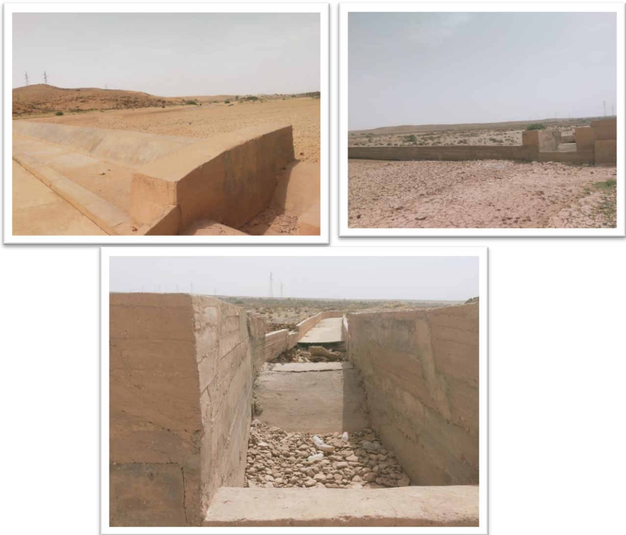
Photo n° 16 : Sed Difel (évacuateur de crue) (Labachi.H,2022)
