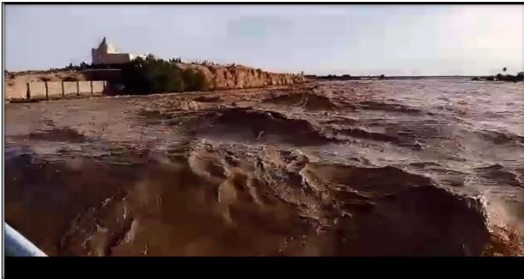
Photo n° 7a : Débordement des eaux de l'Oued Djedi sur le pont,06 Mai 2021 (Labachi hamza)
