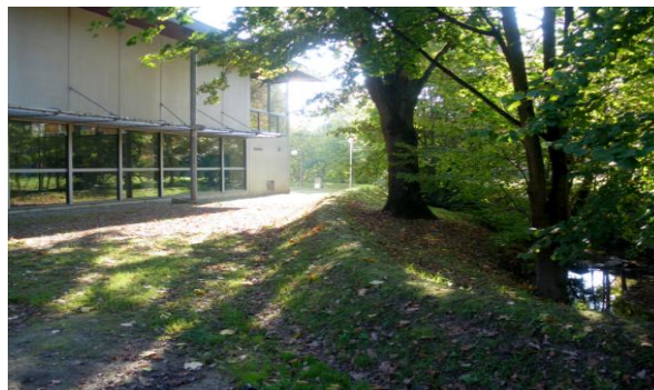
Photo n° 1:Digue en terre
