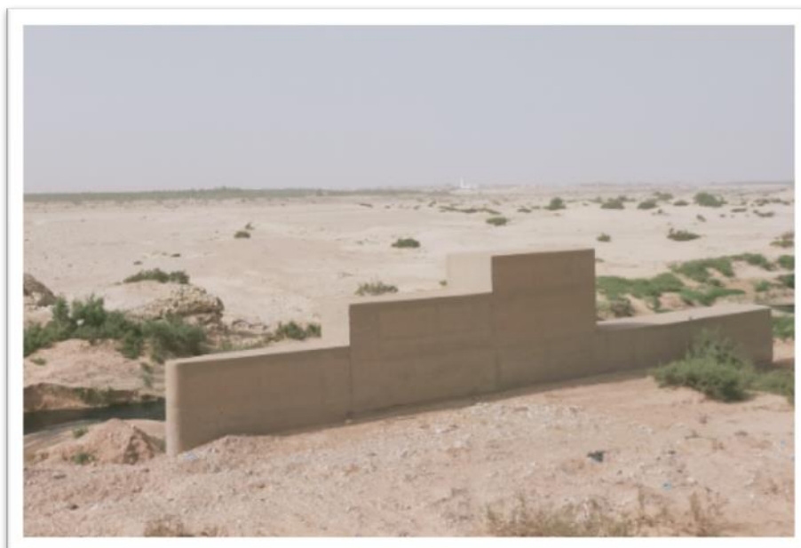
Photo n° 15 : Evacuateur de crue Oued Djedi, (Labachi.H,2022)
