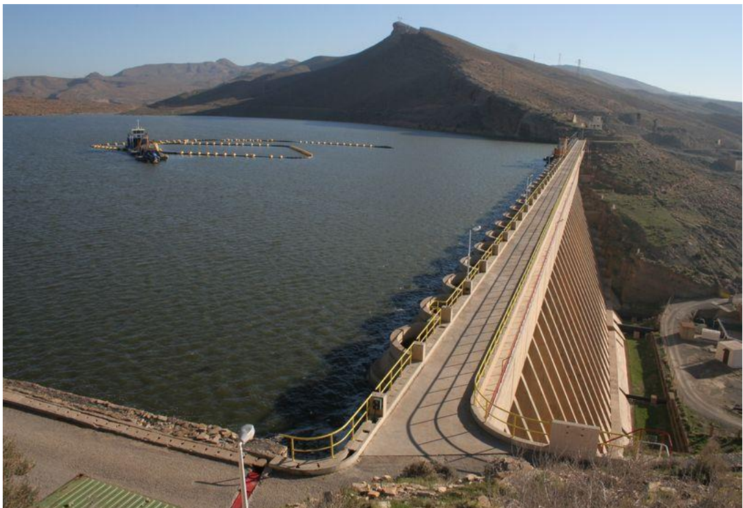
Figure II 4: Barrage d'El k'sob: Barrage à voûtes multiples en béton armé.
