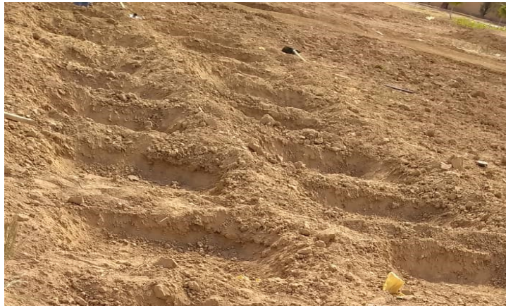
Photo 03 : nivellement du sol et réglage des bordures des parcelles
