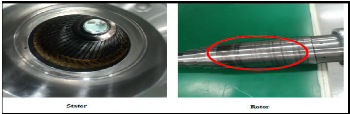
Figure I.8. Frottement rotor-stator d'un moteur à induction causé par un défaut d'excentricité [12]
