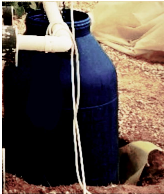
Figure 7 : bassin de récupération
