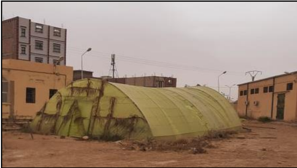
Figure2: Vue de l'extérieur de la serre expérimentale
