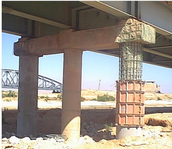
Figure 11. Renforcement des fûts dégradés
