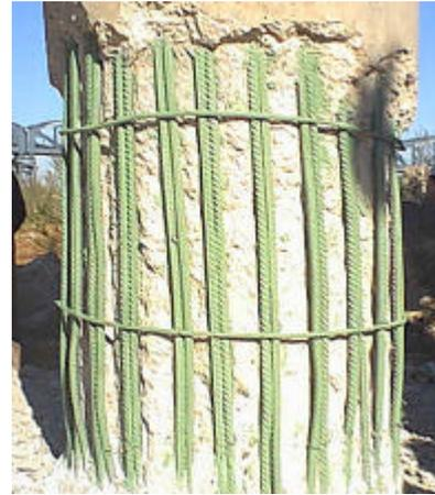
Figure 10. Traitement des armatures corrodées
