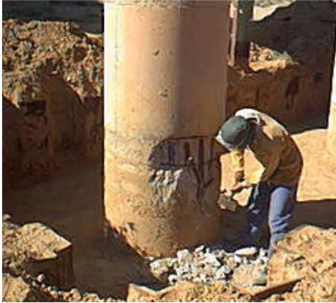
Figure 9. Piquage du béton
