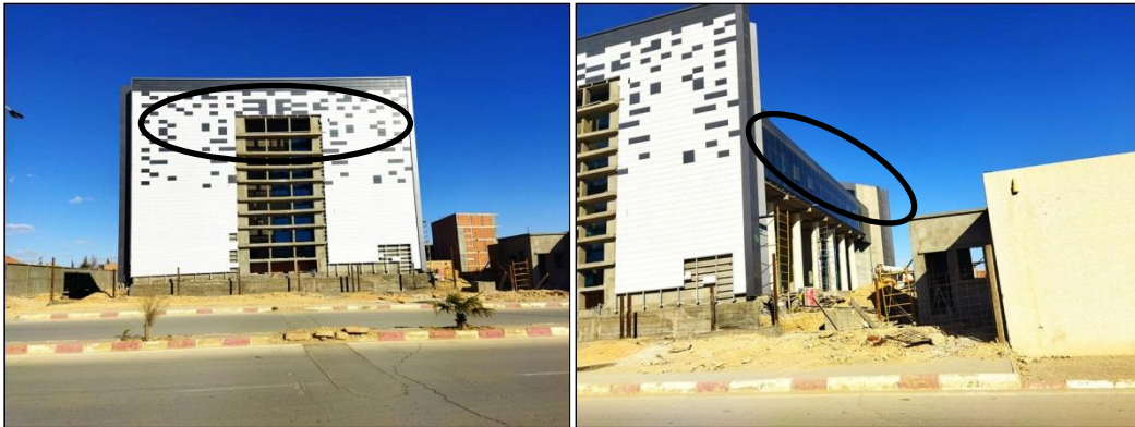
FIGURE : 11 direction de l'équipement public de biskra (nouveau) SOURCE : AUTEUR 2021
