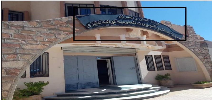
FIGURE : 38 panneau d'identification de D E P illizi SOURCE : AUTEUR 2021
