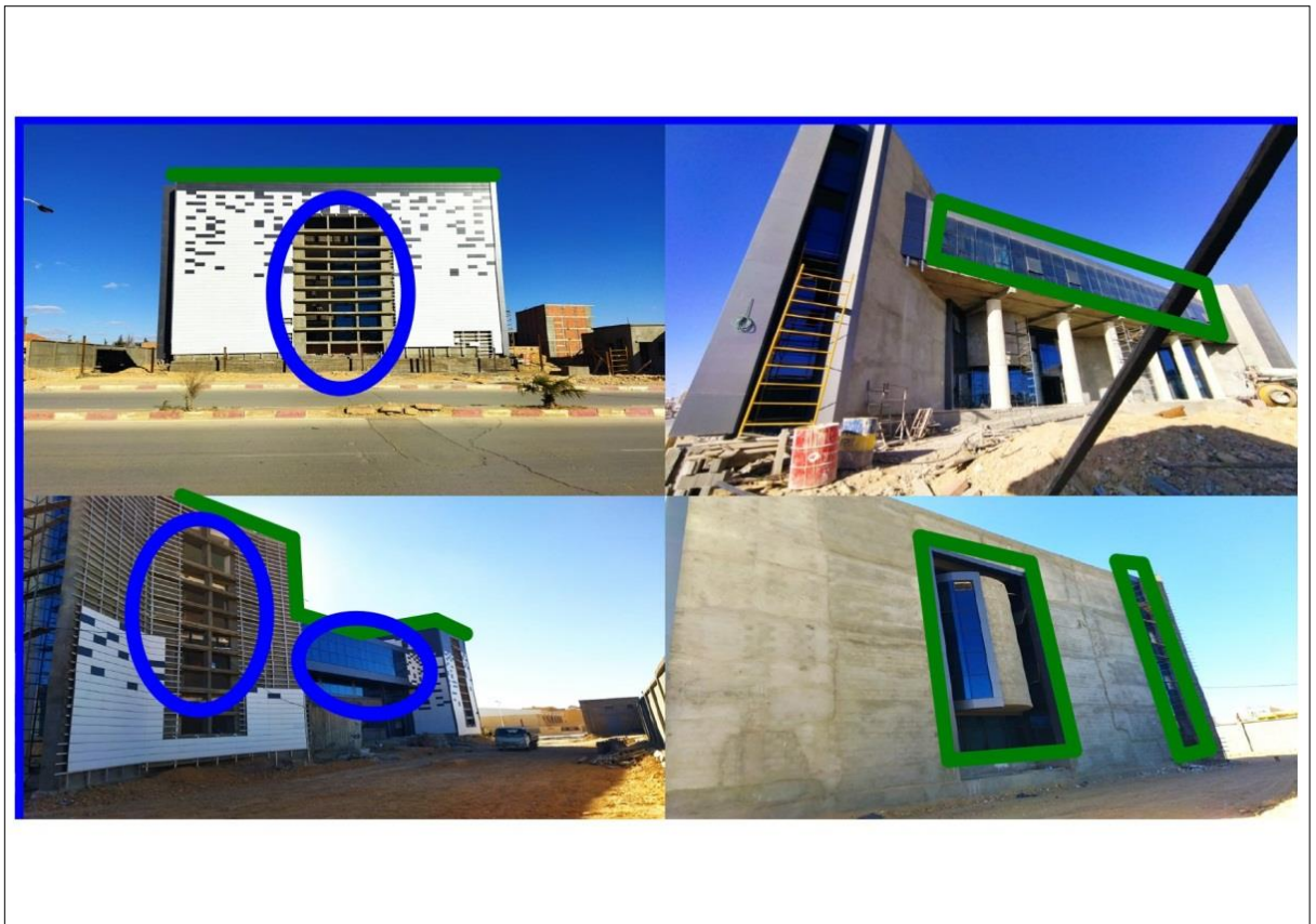
FIGURE : 07 traitement des facades de D E P de biskra (nouveau) SOURCE : AUTEUR 2021
