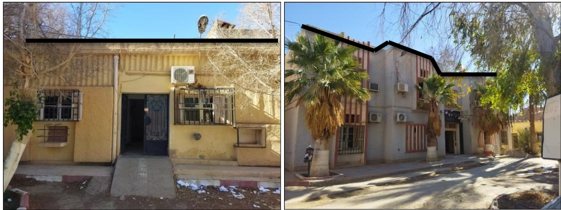
FIGURE : 21 les facades des blocs de D E P biskra (ancien) SOURCE : AUTEUR 2021
