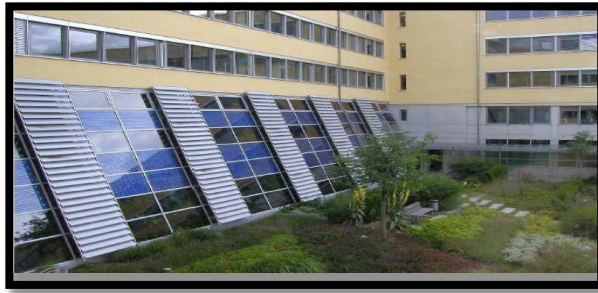
Figure 33 : les modules photovoltaïques translucides.
