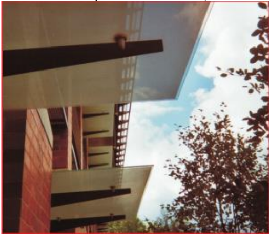
Figure 19 : Un light shelf (arch. Bennetts associate) ( Alain Liébard et André De Herde, Concevoir, Edifier et Aménager avec le développement durable, Traité de l'architecture et d'urbanisme bioclimatique, p274b).
