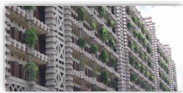
Figure 37: Façade de l'Eastgate
