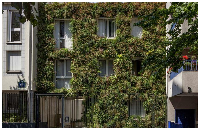
Figure 41: Traitement façade ouest
