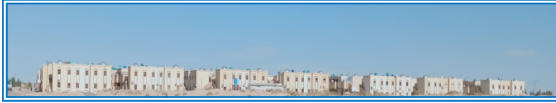
الصورة 15 : الواجهة العمرانية للمجمع السكني النصف جماعي المجاور للأرضية
