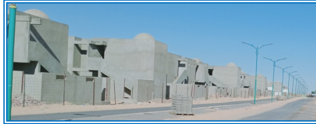
الصورة 16 : الواجهة العمرانية للمجمع السكني الترقوي النصف جماعي
