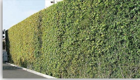
الشكل (23) جدار أخضر ناضج باستخدام نظام لوحة التعريشة المعياري
