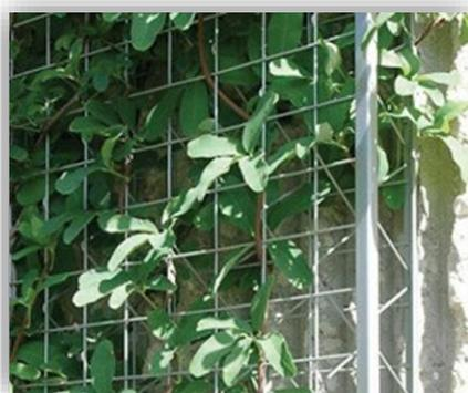
الشكل (22) صورة مقربة لنظام لوحة التعريشة المعياري
