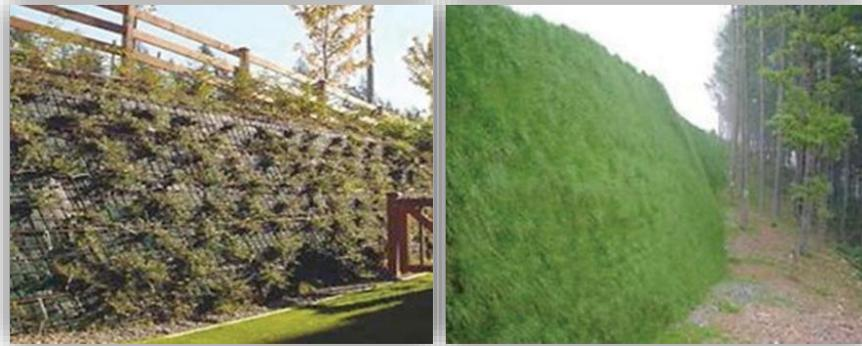
الشكل (36) صور تمثل جدران المناظر الطبيعية التي تستخدم عادة لتقليل الضوضاء المصدر: TensarEarth Technologies
