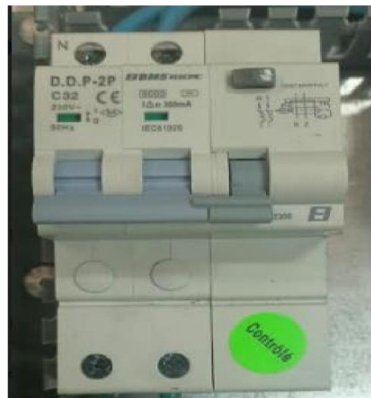
Figure 3.28 :disjoncteur differntioniel bipolaire c32
