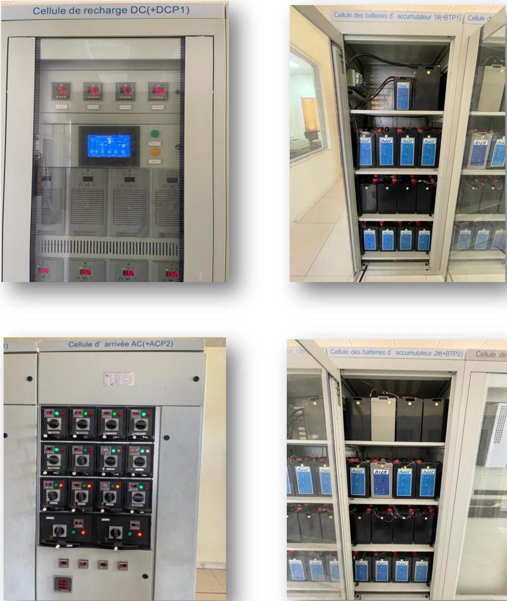
Figure 53 les 4 cellules des batteries d'accumulateur
