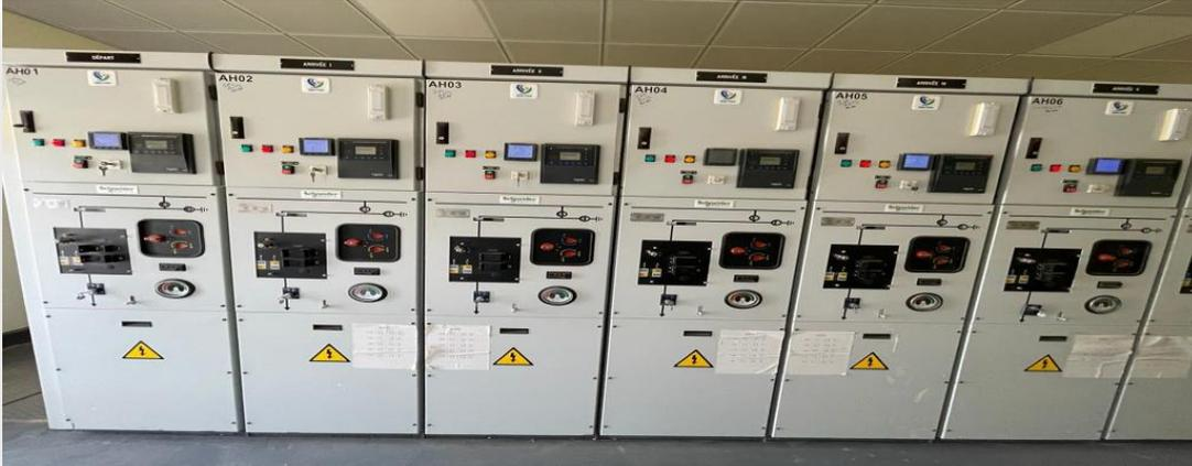
Figure 37 les armoires de poste d'évacuation MT de la centrale El-Hedjira Ouargla
