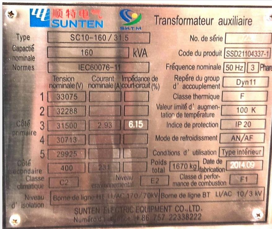
Figure 43 de caractéristiques de transformateur auxiliaire
