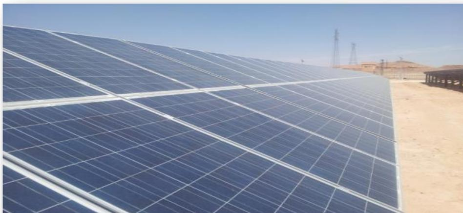
Figure 12 Panneaux en silicium poly-cristallin
