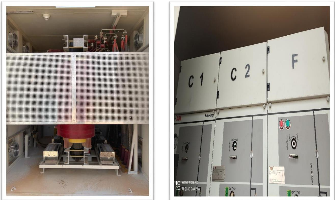
Figure 31 l'intérieur de transformateur les deux côtés
