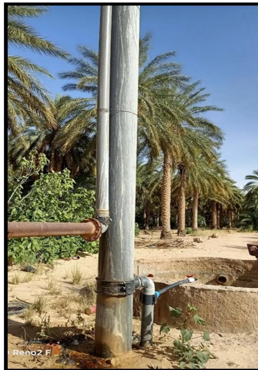
Figure31 : Forage d'irrigation de palmeraies dans la région d'étude (exploitation n°22).
