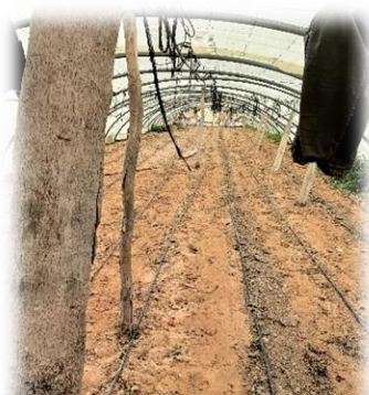
Figure 26: dégâts du vent( originale2022 )
