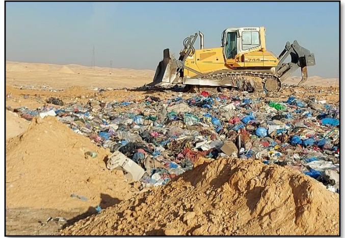
الشكل رقم (88): التغطية النهائية للنفايات بالتربة المصدر : التقاط الطالبة
