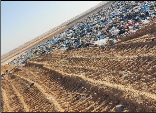
الشكل رقم (88): التغطية النهائية للنفايات بالتربة المصدر : التقاط الطالبة
