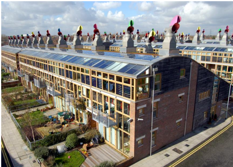
Image 12 : Photos réelle du quartier
