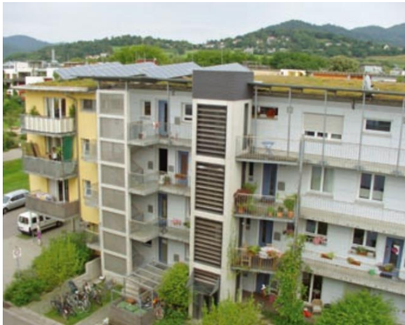
Image 9 : Les toitures végétalisées.
