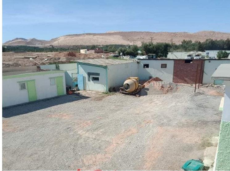
شكل 29: محطة رفع المياه سيدي غزال
