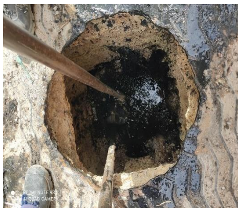
شكل 34: انسداد الشبكة بسبب رمي النفايات الصلبة
