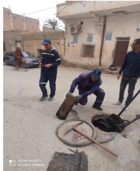
شكل 35 : يوضح تلوث و انسداد شبكة الصرف الصحي
