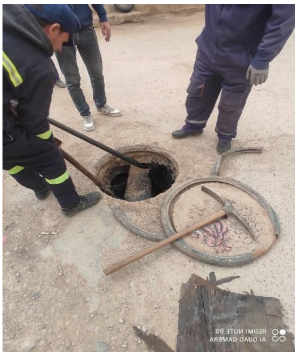
شكل 35 : يوضح تلوث و انسداد شبكة الصرف الصحي
