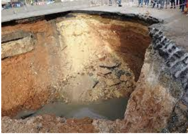
شكل 18: صورة توضيحية لهبوط التربة في مكان عمومي
