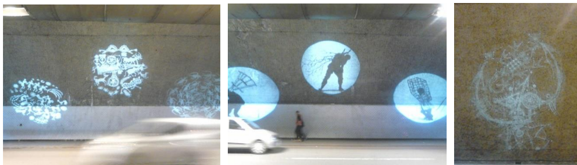
Figure II-27 : Mise en lumière du tunnel des facultés -Alger (AUTEURE, 2014) Alger, le tunnel des facultés, 15 décembre 2014, 15:00
