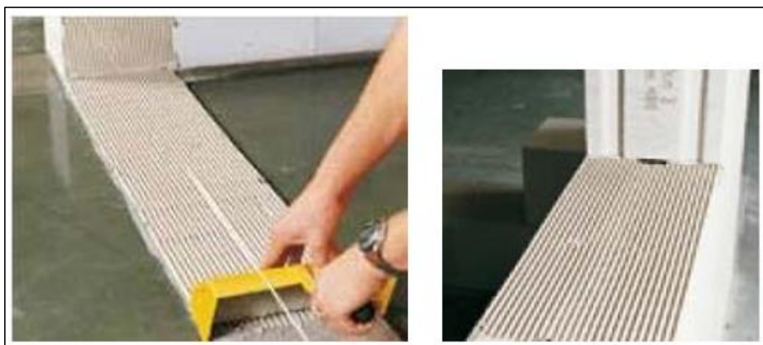
Figure: pose de mortier c Source : construire en béton cellulaire.
