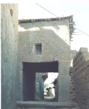
Photo 7 - 5: Arc aménagé au dessus d'un Passage Couvert (source : auteur1999).
