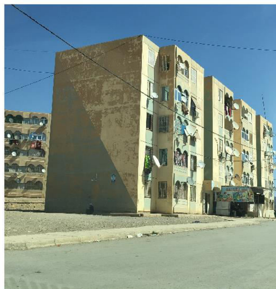
Photo 7 - 13 : Façade d'un bâtiment dans la ZHUN d'Arris (Source : Auteur, 2017)
